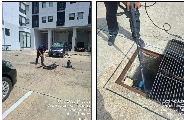
รูปภาพที่ 2.35 การขุดลอกตะกอนในรางระบายน้ำ
